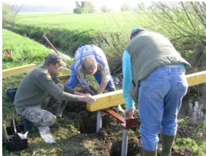
Die Brückenpfeiler werden gesetzt
