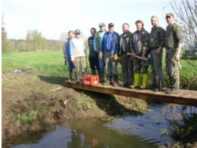
Belastungsprobe für die neue Brücke...
